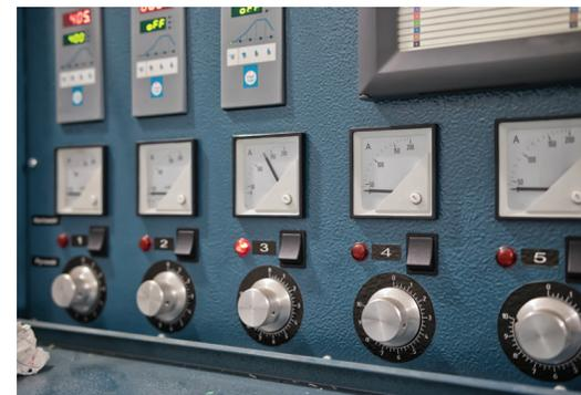
Son utilizados en las instalaciones de control, mando y transmisión de mediciones eléctricas, o señalización de equipos eléctricos en general.
