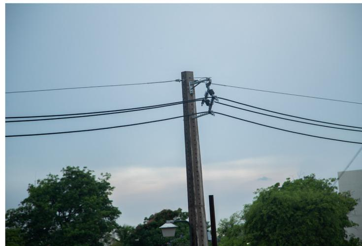
Los cables protegidos con aislación multicapa, INPAPRO MT son utilizados en redes de distribución aéreas compactas. Son los reemplazantes naturales de los cables de aluminio desnudo para las zonas arboladas y en zonas con probabilidad de contactos accidentales donde se exigen un elevado grado de seguridad. Posee una cobertura resistente a la radiación solar, a la abrasión y con elevada resistencia a la formación de caminos conductores (tracking).
