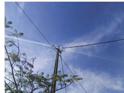
Tiene una ventaja sobre los cables desnudos, porque podrán ser instalados en zonas arboladas y en locales donde se tiene poco espacio físico.
